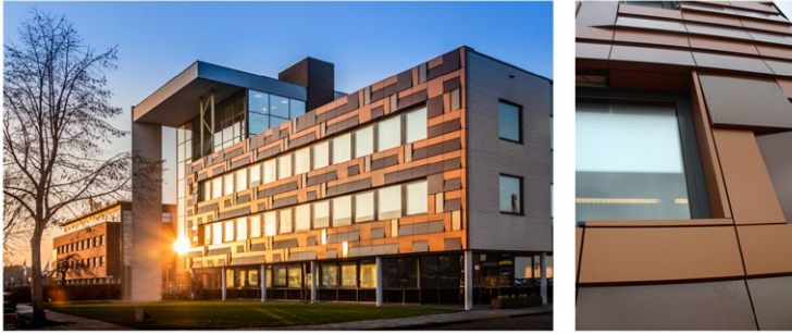
Figuur 13. Gekleurde façade gebaseerd op standaard zonnepanelen met geprinte structuren op glas [96].
